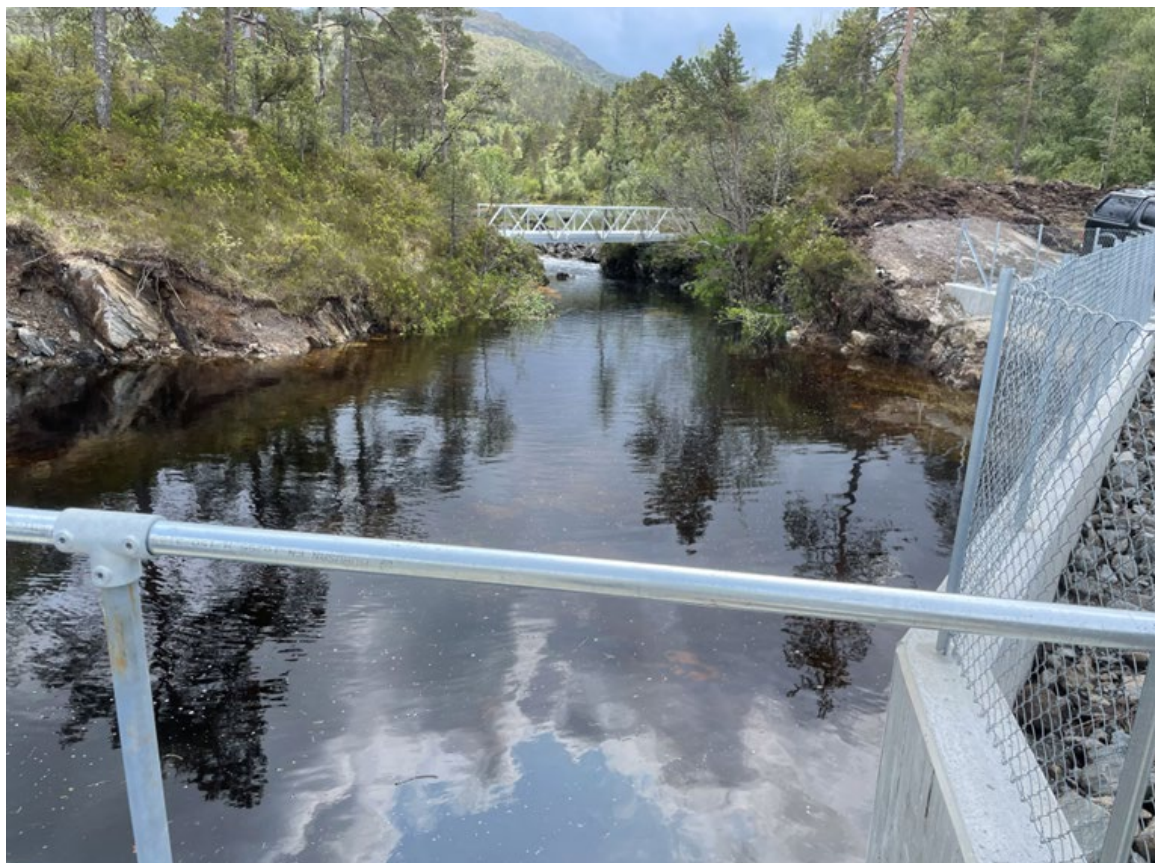
Photo: Kjell Magne Haugen, Project Smådalselva
